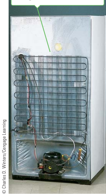
Figura 12.15 Parte trasera de un refrigerador doméstico. El aire que rodea las bobinas es el depósito caliente.
