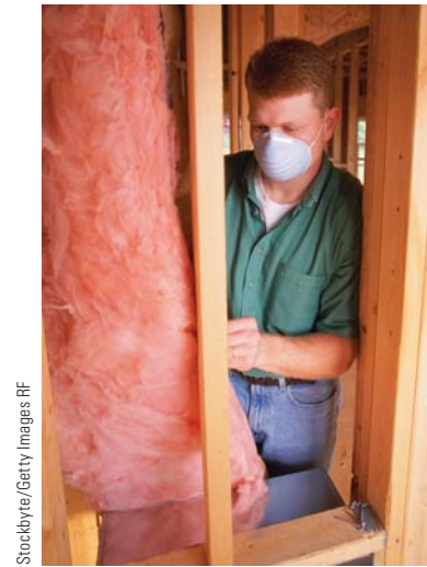
Un trabajador instala aislamiento de fibra de vidrio en un hogar. La máscara protege al trabajador contra la inhalación de fibras microscópicas, que podrían ser peligrosas a su salud.
